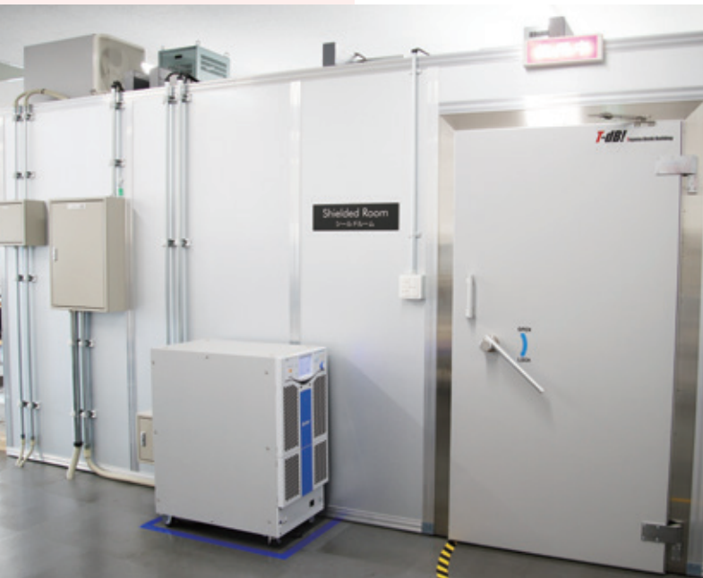
EMC試験センター シールドルーム外観
